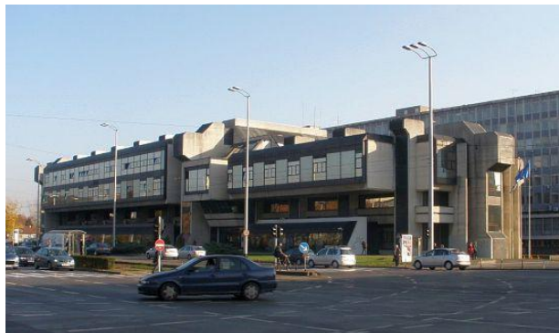
Slika 52.- Zgrada MINGORP-a u kojoj djeluje najveći objekt MPRRR-a
