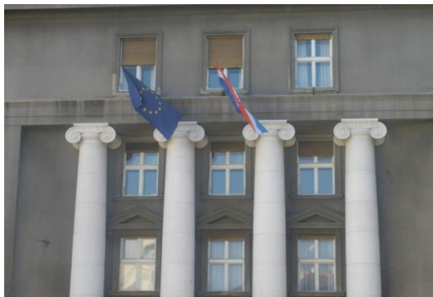
Slika 44.- Zgrada MOBMS-a, Trg Hrvatskih velikana 6
