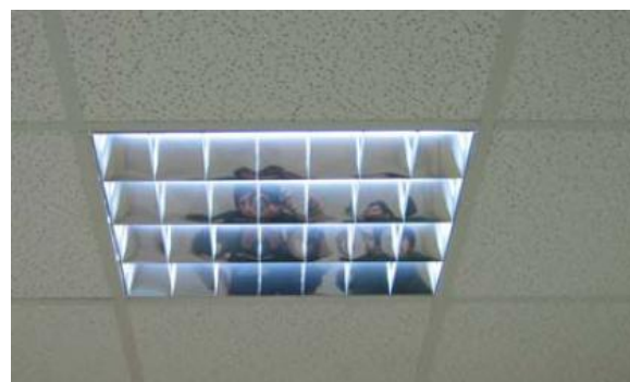
Slika 31.- Zamjena rasvjete na objektu Jug - ušteda oko 7.500 kn/godišnje.
